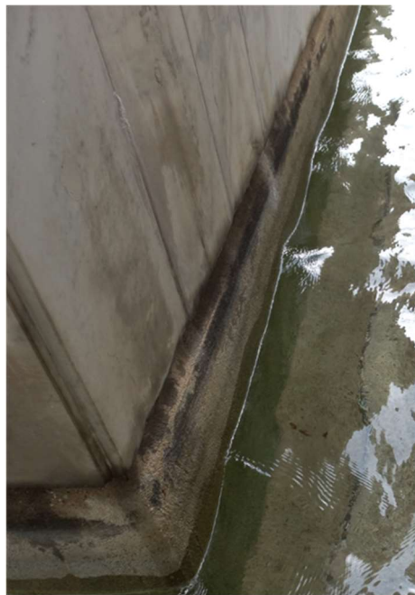
Figura 8 - Deterioração por agente químico nos brises
