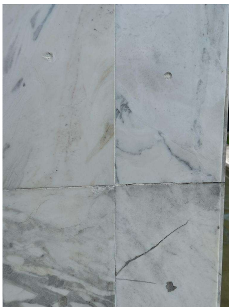
Figura 10 - Fissuras e trincas nos brises
