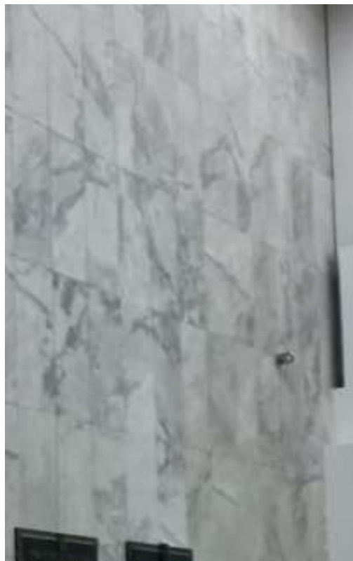
Figura 5 - Deterioração do mármore
