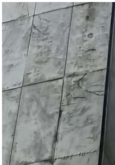
Figura 10 - Fissuras e trincas nos brises
