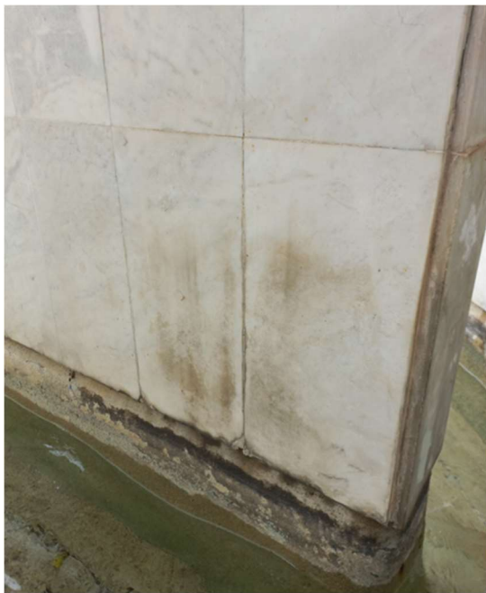
Figura 8 - Deterioração por agente químico nos brises
