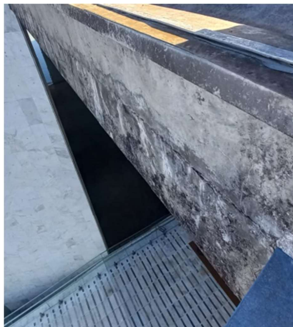
Figura 16 - Deslocamento e desagregação da marquise
