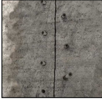
4 - INSTALAÇÃO DOS BICOS DE PERFURAÇÃO
