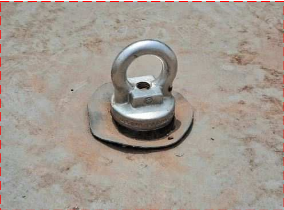
DETALHE 02 - OLHAL DE ANCORAGEM Ø 3/8" - TESTAR S/ ESCALA
