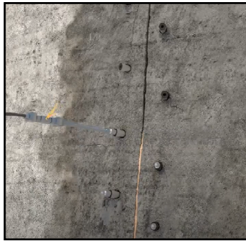
5 - INJEÇÃO DE RESINA FLEXÍVEL / MC-INJEKT 1264 COMPACT
