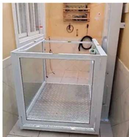
Figura: exemplo de plataforma elevatória com mecanismo fuso-mecânico, semi-cabinada.
