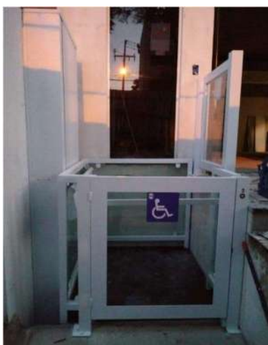
Figura: exemplo de plataforma elevatória com tração hidráulica, semi-cabinada.
